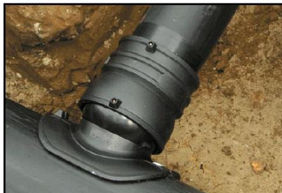
FASE 4: Collegamento ai terminali della saldatrice con impostazione dei parametri di saldatura mediante riconoscimento automatico o penna ottica e saldatura
