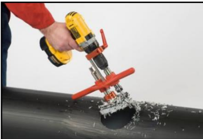
FASE 2: Foratura con apposito utensile e pulizia della superficie della tubazione
