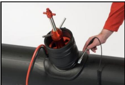
FASE 4: Collegamento ai terminali della saldatrice con impostazione dei parametri di saldatura mediante riconoscimento automatico o penna ottica e saldatura
