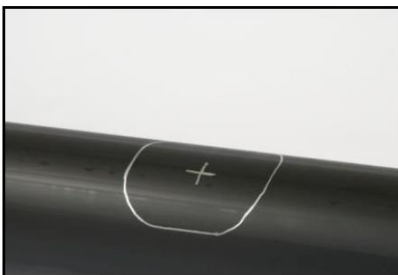
FASE 1: Raschiatura e pulizia della superficie della tubazione
