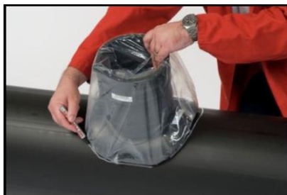
FASE 1: Raschiatura e pulizia della superficie della tubazione
